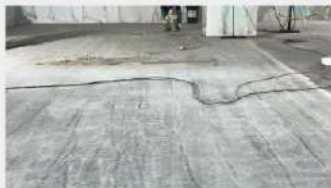
SUBSTRATO (CONCRETO) POLIMENTO | FRESAMENTO FRETAMANETO
