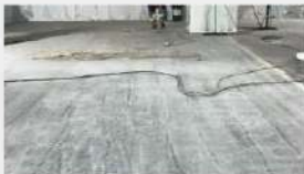
SUBSTRATO (CONCRETO) POLIMENTO | FRESAMENTO FRETAMENTO
