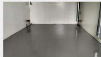
REVESTIMENTO APLICADO E PINTADO
