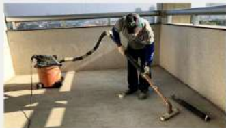
SUBSTRATO (CONCRETO) POLIMENTO | FRESAMENTO FRETAMENTO
