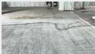
SUBSTRATO (CONCRETO) POLIMENTO | FRESAMENTO FRETAMENTO
