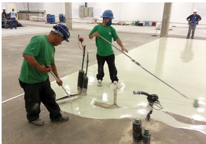
SISTEMA URETANO AUTONIVELANTE EM APLICAÇÃO
