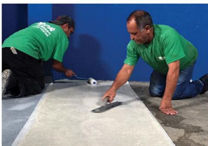
SISTEMA URETANO TEXTURIZADO EM APLICAÇÃO
